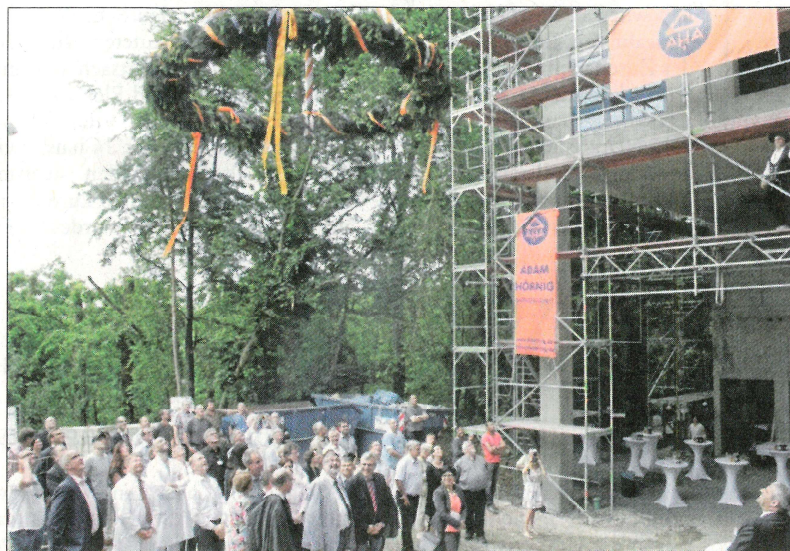
Alle Blicke nach oben: Der Richtkranz wird hochgezogen.
