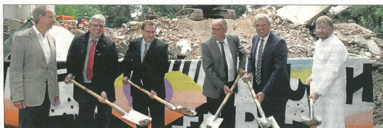
Für den ersten Spatenstich griffen die Verantwortlichen symbolisch zum Spaten. Im Mittelpunkt des offiziellen Akts stand danach aber der Baggerfahrer, der hinter ihnen die letzte Mauer des alten Talbaus einriss. Eine nachhaltige Aktion, denn die Graffiti-Bruchstücke sollen später zugunsten der Stiftung St. Vincenz-Hospital versteigert werden. Von links Architekt Michael Hamm, Bürgermeister Dr. Marius Hahn, Architekt Willi Hamm und vom St. Vincenz-Krankenhaus Verwaltungsratsvorsitzender Erwin Reuhl, Geschäftsführer Guido Wernert und der Ärztliche Direktor Dr. Thomas Heß. Fotos: Heidersdorf
